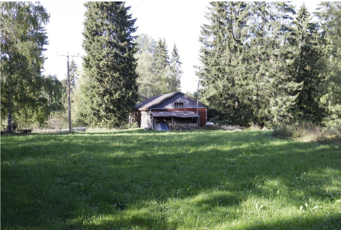
Kuva 56 Talousrakennus Rumootantien lähellä.
