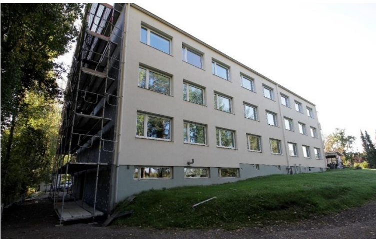
Kuva 119 Vanhainkodin luoteissiipi on julkisivusaneerattu vuonna 2023.
