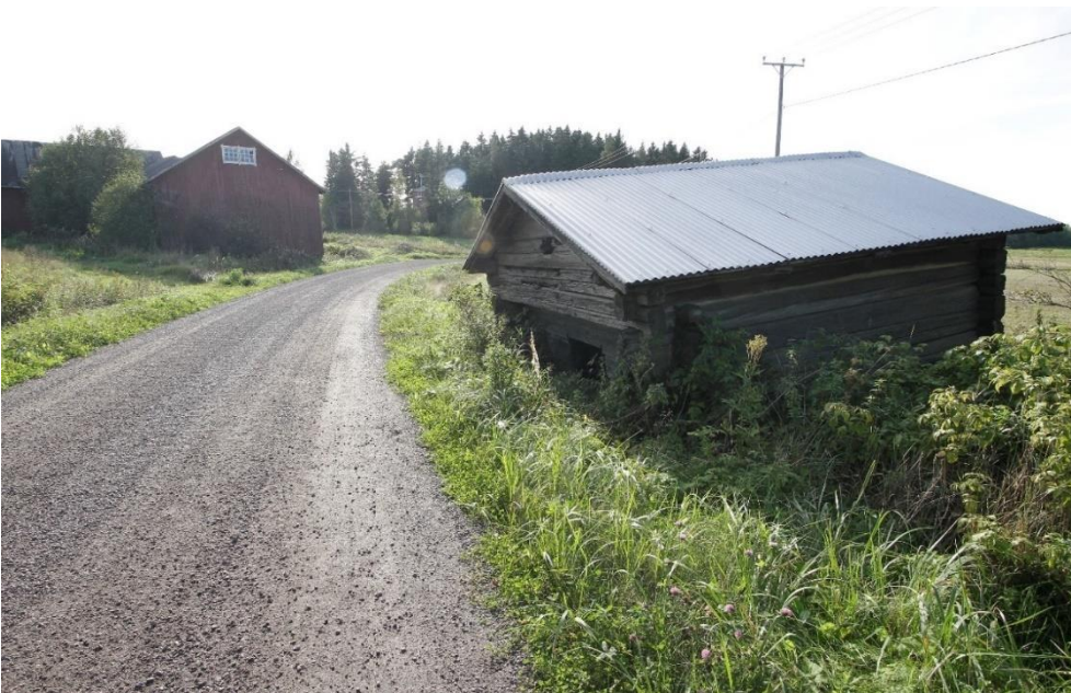
Kuva 98 Otsallinen hirsiaitta sijaitsee aivan Nurmintien varressa tien pohjoispuolella. Aitan perustukset ovat painuneet etenkin tien puolella ja luultavasti myös tien pintaa on nostettu tien kunnostusten yhteydessä. Taustalla näkyy tilan kookas lato.
