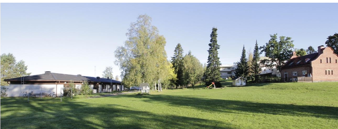
Kuva 120 Vanhainkodin länsipuolelle on rakennettu matalia aumakattoisia rivitaloja 1980-luvulla. Kuvan oikeassa reunassa näkyy Idmanin aikainen viljamakasiini ja sen takaa häämöttää vanhainkodin rakennukset. Vanhainkodin ympäristö on puistomainen.
