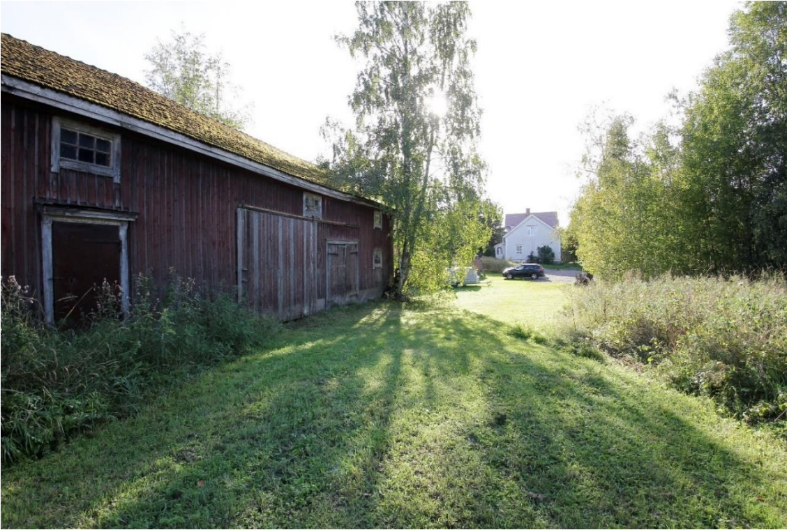
Kuva 104 Näkymä talousrakennuksen edustalta kohti päärakennusta. Kuvassa näkyy talousrakennuksen pohjoisjulkisivu ja päärakennuksen itäpääty.
