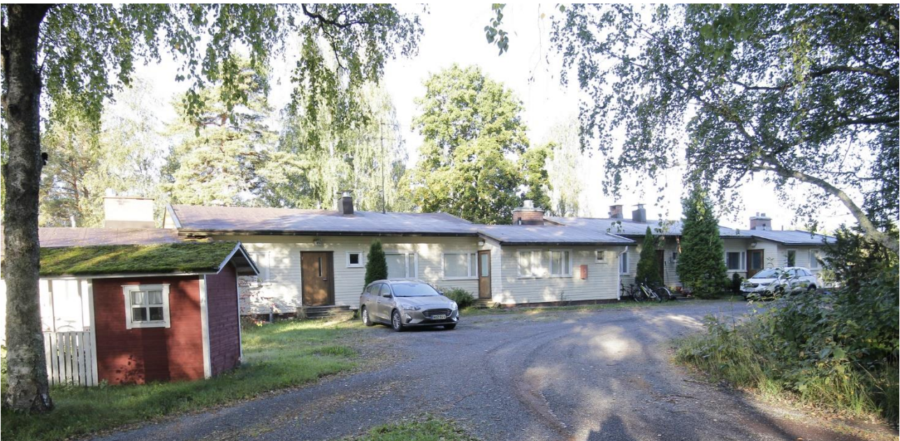
Kuva 124 Kirjatoimen työntekijöille 1960-luvulla rakennetut rivitalot sijaitsevat entisen toimitalon ja Näsijärven rannan välissä. Läntisempi rivitaloista on massoitteeltaan monimuotoisempi kuin itäisempi rivitalo.
