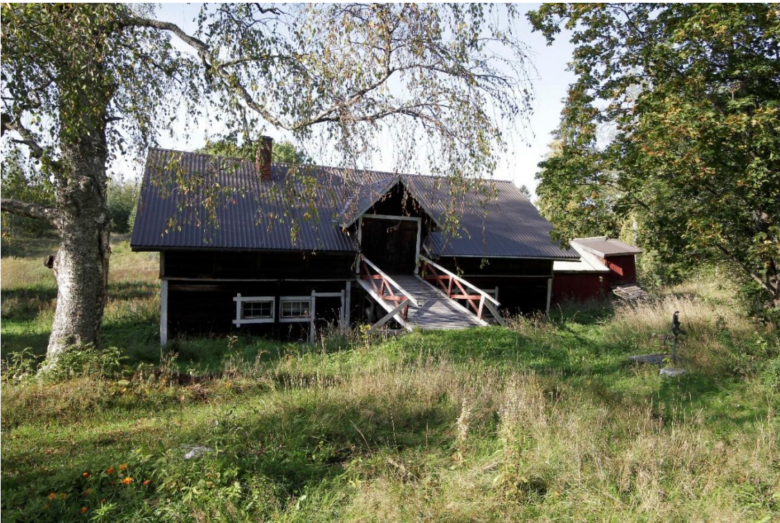
Kuva 52 Hirsisen navetan kaakkoisjulkisivu. Navetan oikealla puolella näkyy pihapiirissä oleva uudempi talousrakennus.
