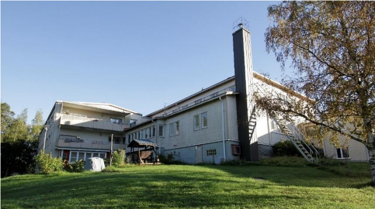
Kuva 118 Vanhainkoti Nurmikodin rakennuskokonaisuus kuvattuna etelästä päin.
