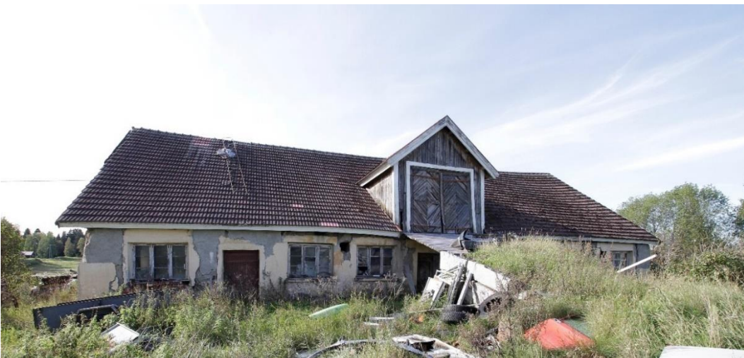
Kuva 96 Entinen navetta on rakennettu vuonna 1923. Vailla käyttöä olevan rakennuksen ympäristö on heinittymässä.
