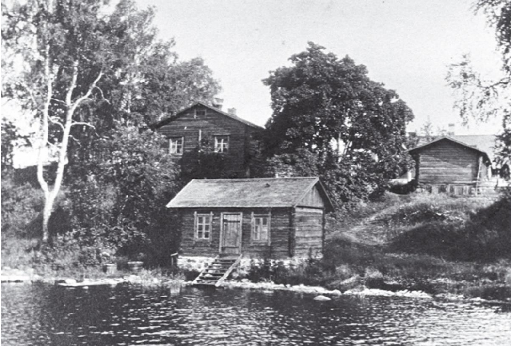
Kuva 82 Kokin pihapiiri järveltä 1900-luvun alussa. Kuva otettu kaakon suunnalta pihapiiriin nähden. Rannassa olevan saunamökin paikkeilla on nykyisinkin sauna. Saunan takaa näkyy nykyisen päärakennuksen eteläpääty. Nykyinen ikkuna-aukotus vastaa 1900-luvun alun tilannetta, mutta rakennus on vuorattu. Kuvan oikeassa reunassa näkyy aitan pääty ja sen takaa alkuperäisen päärakennuksen kattoa. Kuvälähde: Anneli Salo
