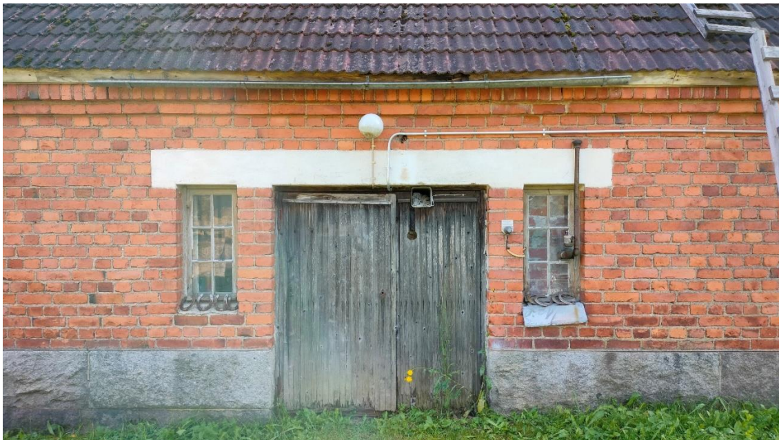
Kuva 108 Tiilinavetan sisäänkäynti pohjoisjulkisivulla.
