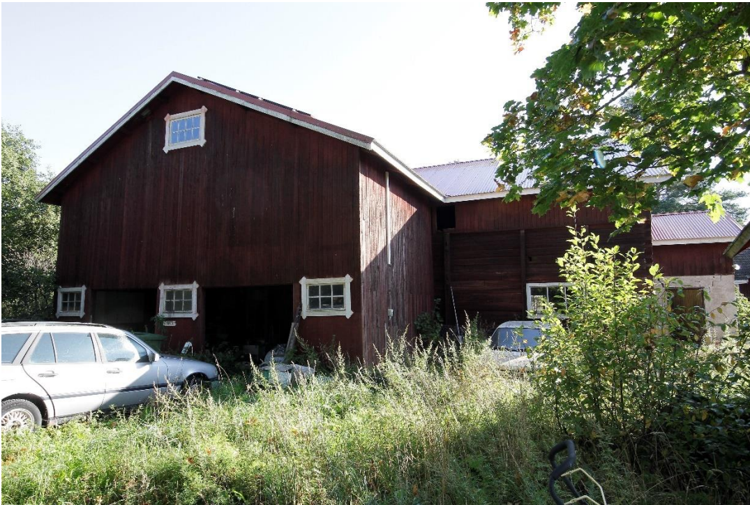
Kuva 44 1900-luvun alussa rakennettu navetta.
