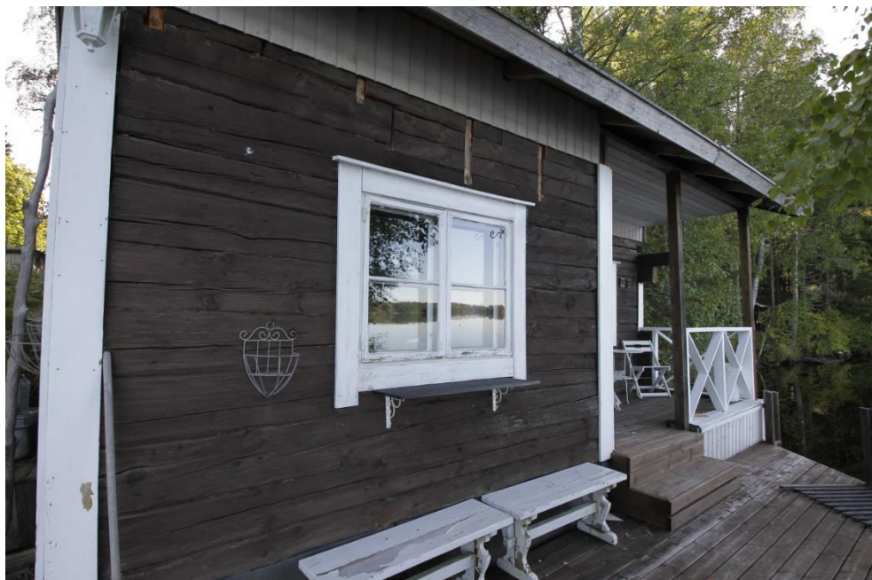
Kuva 32 Niemen luoteisrannalla on hirsirakenteinen saunamökki aivan vesirajassa. Omistajan mukaan saunamökki on vuodelta 1923.
