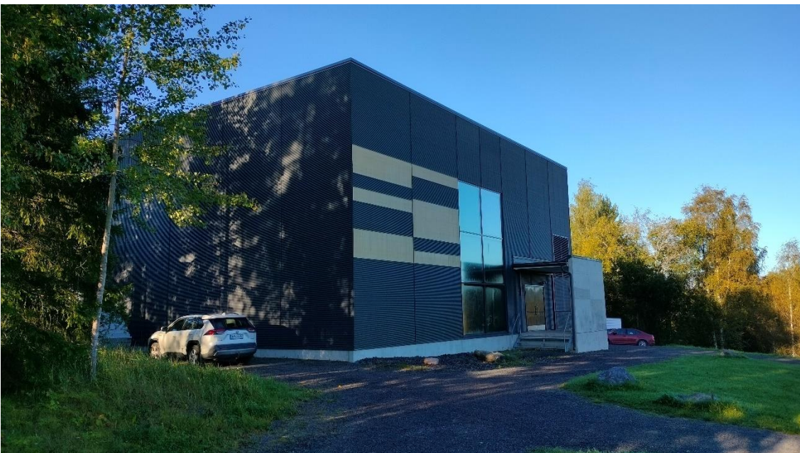
Kuva 128 Koulun länsipäättyyn rakennettu monitoimisalilin laajennus.
