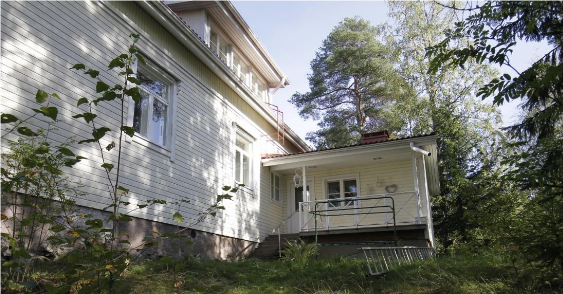
Kuva 60 Asuinrakennuksen eteläjulkisivulla on 1970-luvulta peräisin oleva ns. elintasosiipi pesutiloineen.
