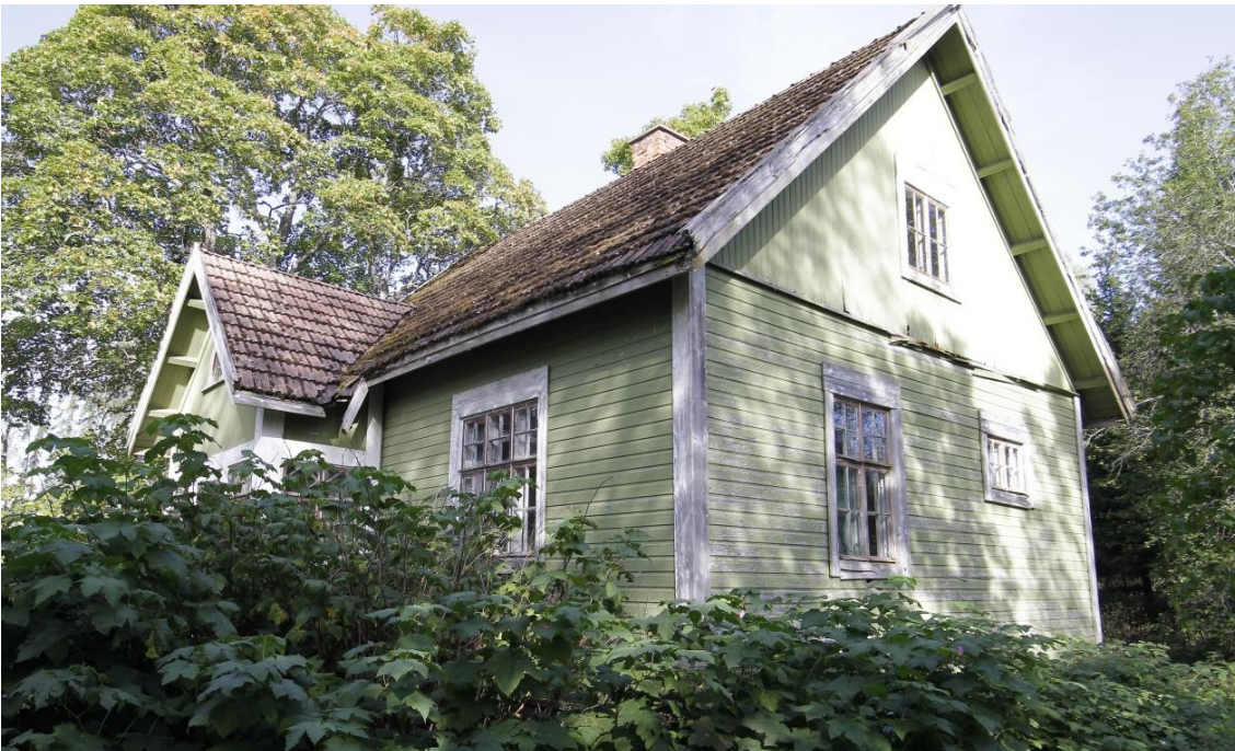
Kuva 92 Kovapään pienempi jugendvaikutteinen asuinrakennus vuodelta 1917 pihapiirin itälaidasta. Kuvassa rakennuksen länsi- ja eteläjulkisivut.
