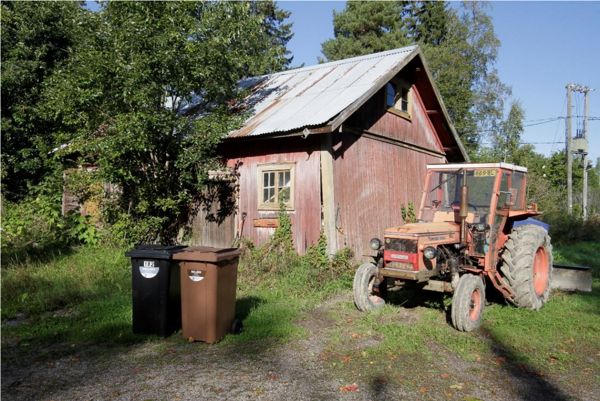
Kuva 37 Talousrakennus muonamiehen mökin länsipuolella on osittain hirsi-, osittain rankorakenteinen.
