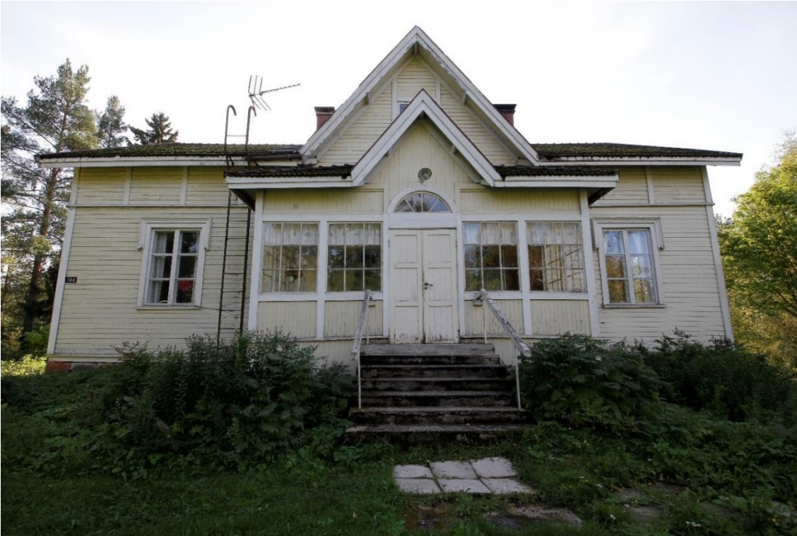
Kuva 49 Pihlajamäen päärakennuksen koillisjulkisivu.
