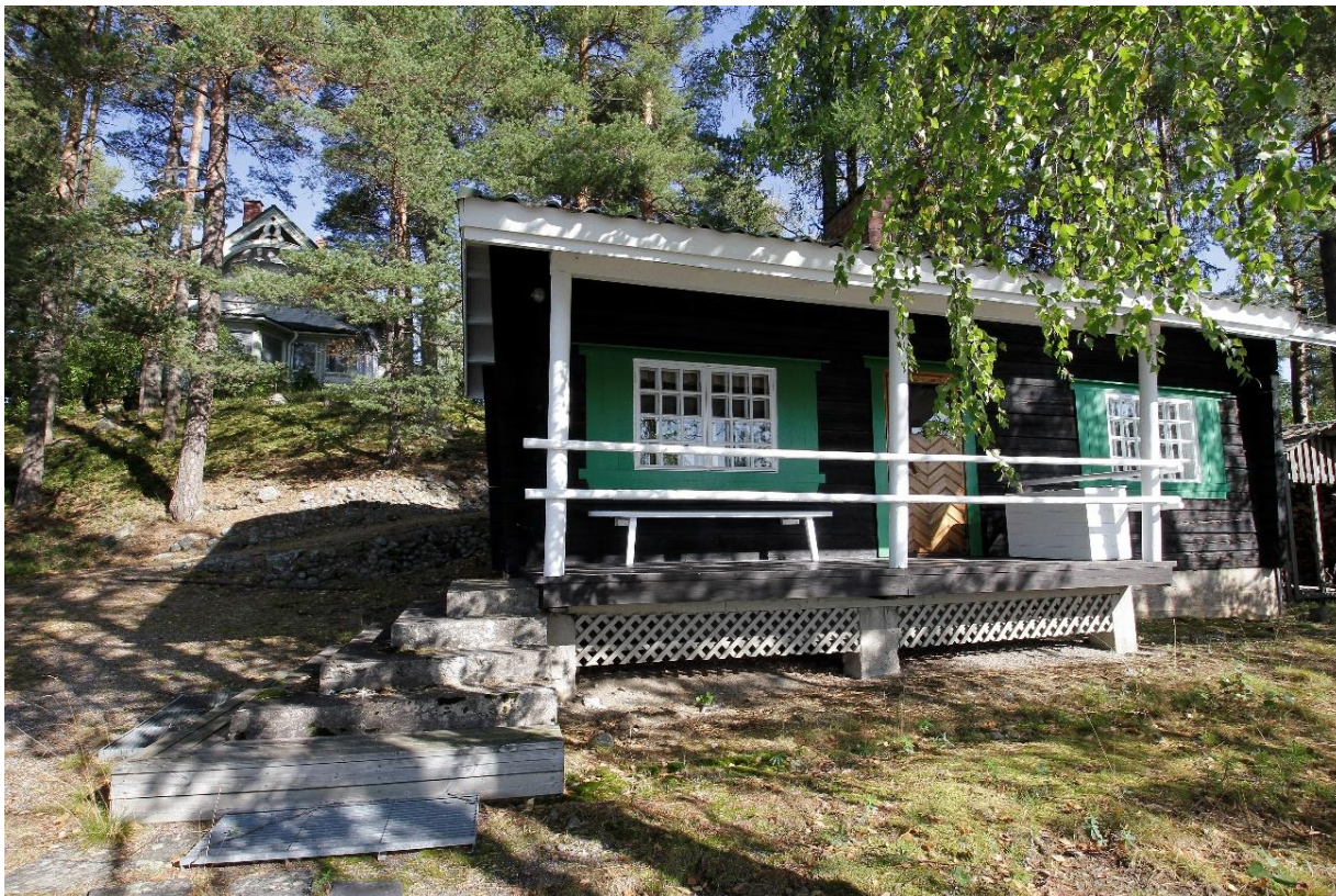
Kuva 21 Vuonna 1950 rakennettu rantasauna, taustalla päärakennuksen luoteen puoleinen julkisivu.
