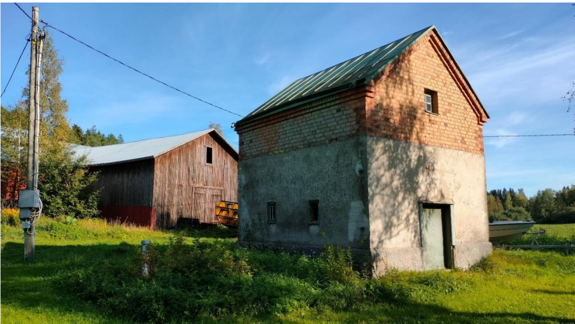
Kuva 71 Tiilinen viljamakasiini pihapiirin eteläreunalta. Kuvan vasemmassa reunassa näkyy talousrakennus, jonka runkoon on hyödynnetty kahden riihen rakenteita. Kuvassa näkyvä rakennuksen länsisiipi on kuitenkin rankorakenteinen.
