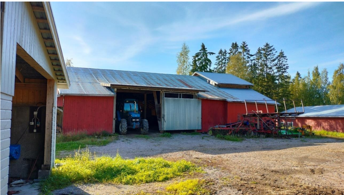
Kuva 75 Talousrakennus, joka on rakennettu yhdistämällä kaksi vanhaa hirsirakenteista riihtä. Toinen riihistä erottuu muuta rakennusmassaa hieman korkeampana. Kuvan vasemmassa reunassa n. 2015 rakennettu konesuoja ja oikeassa reunassa n. 1980–1990-luvuilla valmistunut talousrakennus, jonka takaa näkyy Nurmintien varressa olevan entisen navetan kattoa.
